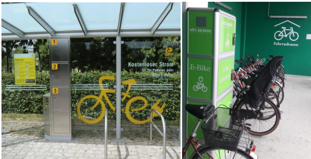
Abbildung 45: Good-Practice-Beispiel für eine überdachte E-Bike Ladestation in Ludwigsburg und einem Fahrradraum in Leipzig
